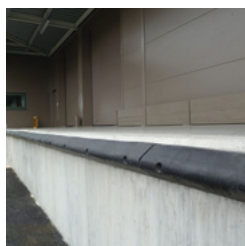
QUAI DE CHARGEMENT
